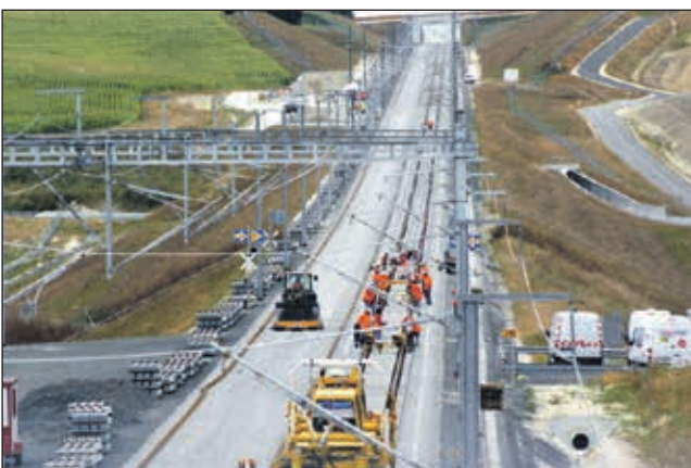
La pose des rails avance au rythme de 7 km par semaine.
