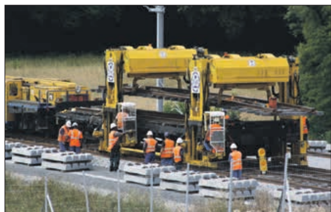
Récupération de la ligne provisoire au fur et à mesure de l'avancée vers Bordeaux.
